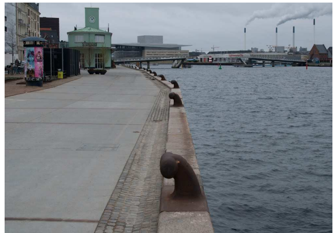
Bolværket mod havneløbet er udført med lodret kajmur og bolværkshammer i granit, hvilket er typisk for Inderhavnen.
