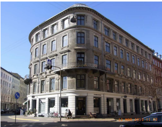
Foto 9. Facadedetaljeringen som dekorationer, gesimser og lignende skal opleves gennem forskellige materialer eller skyggevirkningen og ikke ved at fremhæve dekorationerne med en malerbehandling i anden farve.
