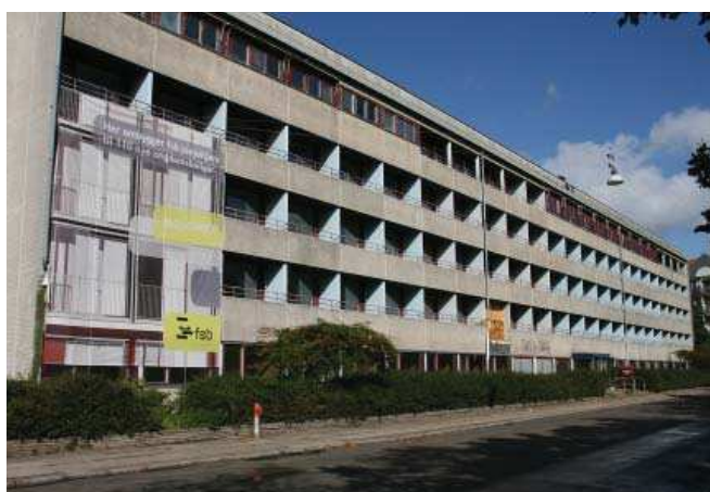
Plejecenteret Øselsgården på Amager ombygges til ungdomsboliger
