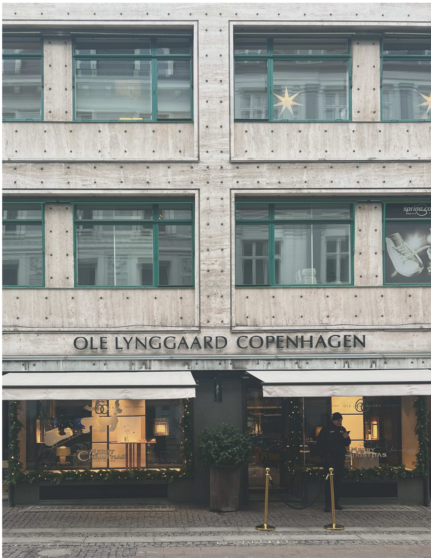
Ny Østergade 4 - Facade
