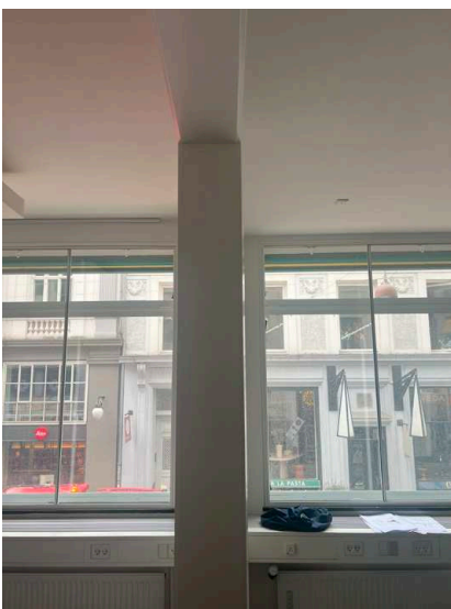
1. sal - Loftet Overgang mellem 1.11 og 1.12, nedhængt loft i 1.11
