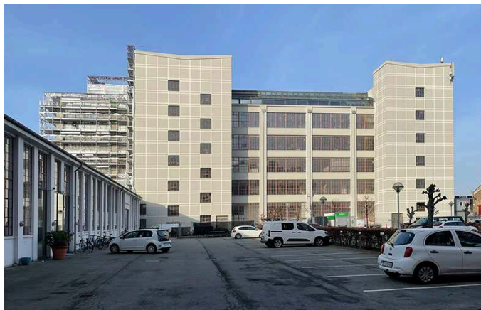
Billedet ses mod nord fra parkeringsplads mod det karakteristiske byggeri på Vermundsgade 40A-B, her under en renovering.
