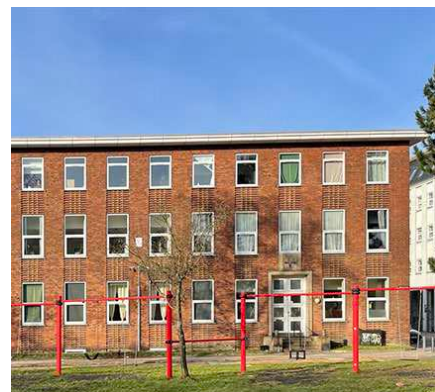
1. Bilfabrikken General Motors administrationsbygning og kantine fra 1932, udpeges som bevaringsværdig.
