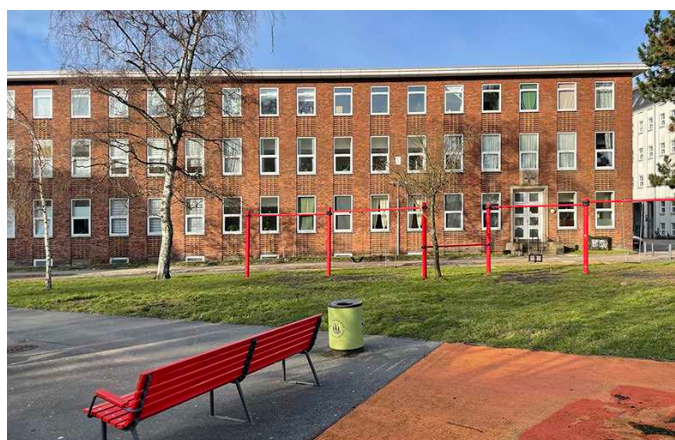
Krakas Plads og administrationsbygningen for tidligere bilfabrik General Motors.
