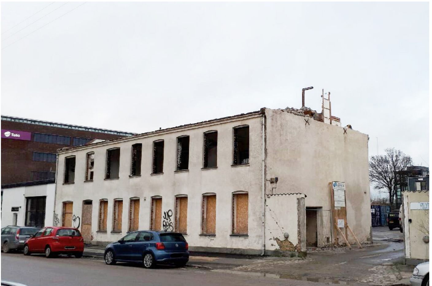
Strandlodsvej 3 efter påbegyndt nedrivning
