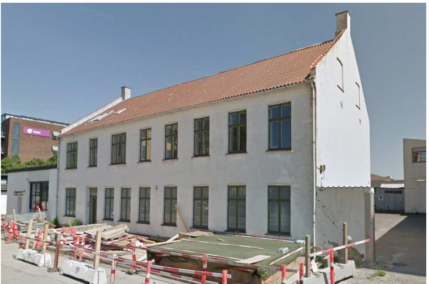
Strandlodsvej 3 før påbegyndt nedrivning
