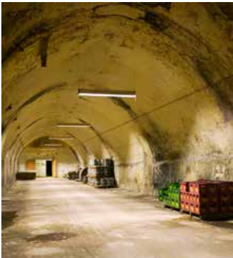
Kælderen under Rød Lagerbygning.
