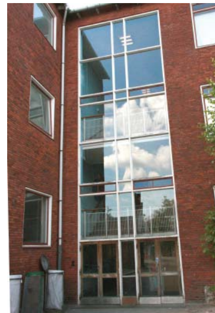
Det vertikale flow i bygningen kan aflæses i glaspartierne ved de sekundære indgange.
