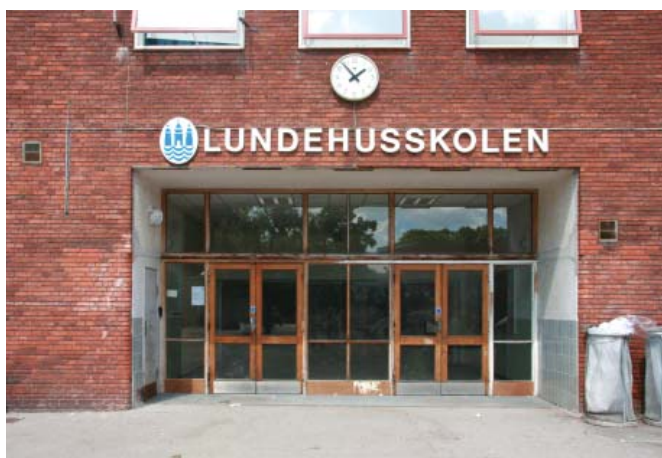
Hovedindgangspartiet er markant.
