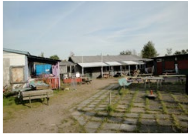
Nokkens nuværende fælleshuse, som foreningen overvejer at erstatte med nybyggeri på en ny fælleslod.
