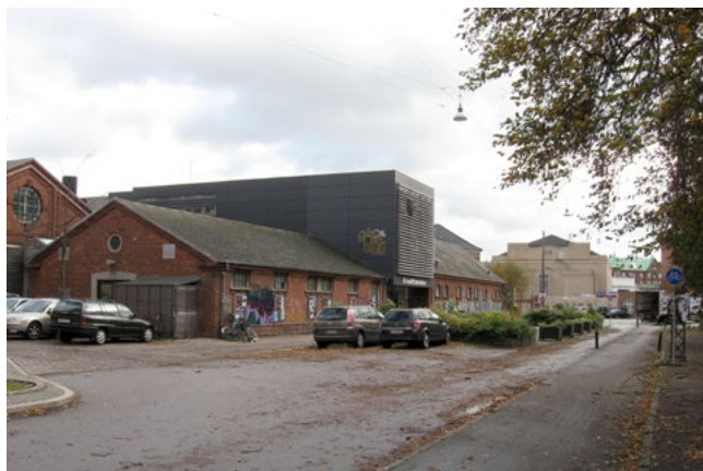
Teatret Krudttønden set mod øst fra Serridslevvej med cykel-slusen i højre side af billedet.
