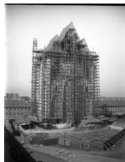
Grundtvigs Kirke kirken under opførelse
