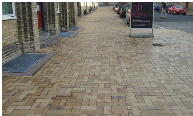
Belægninger på Bispebjerg Torv
