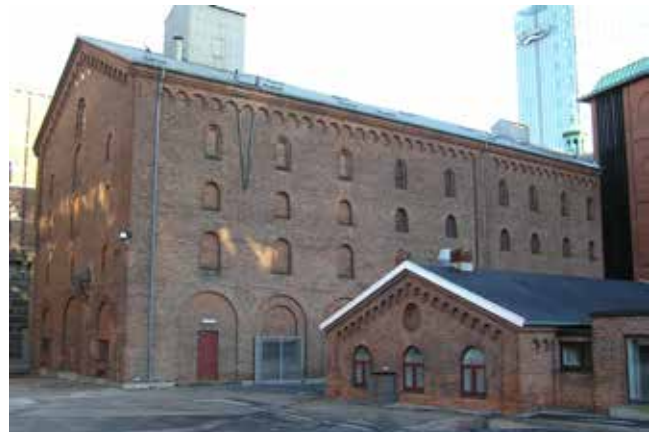
Ved Malteriet ligger det bevaringsværdige Hammershus på Bryggerens Plads.
