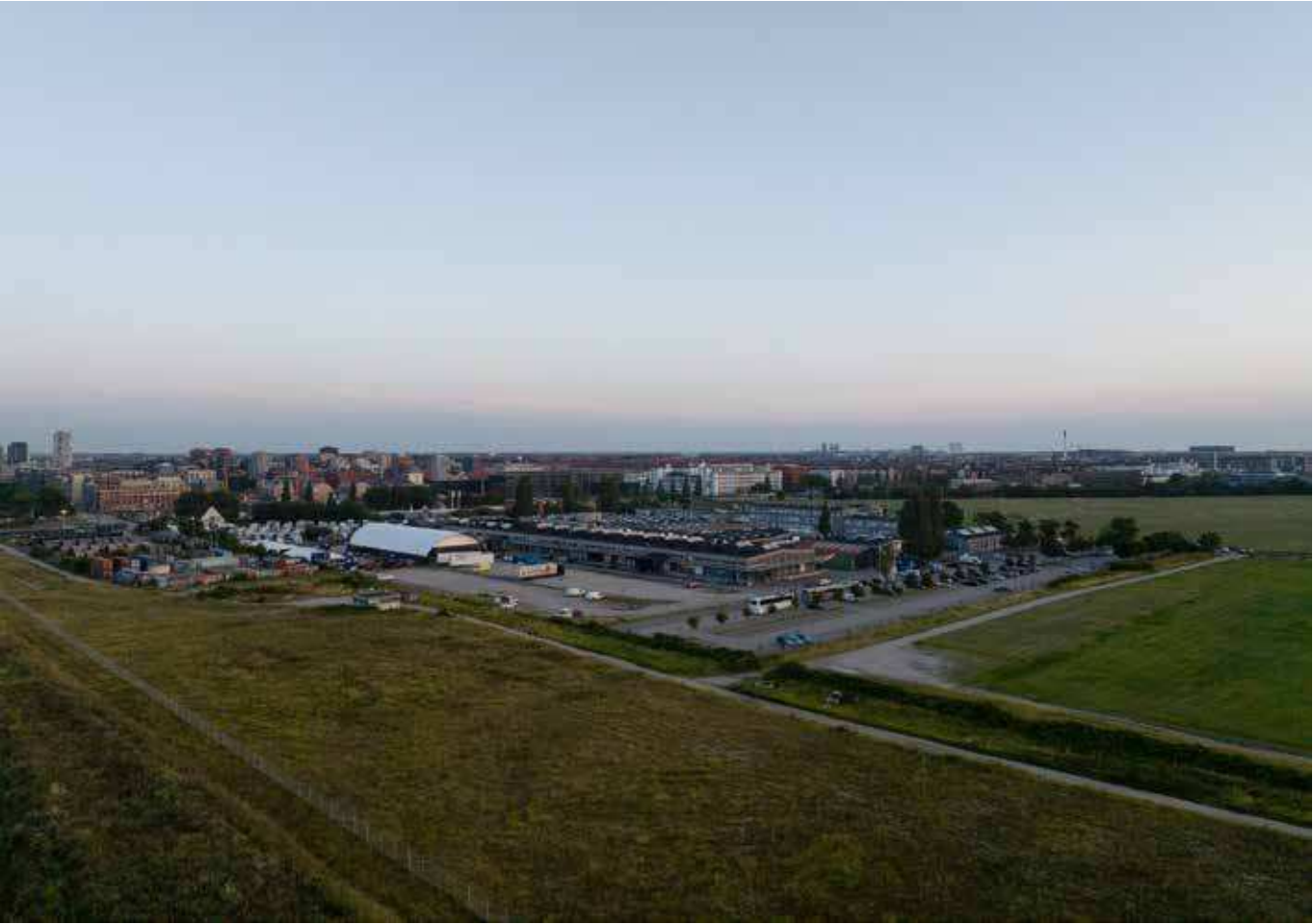
DEN SYDLIGE BYGNINGSENKLA-VE SET FRA LUFTEN.
