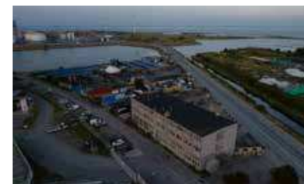
ØVERST: FREDET KRUDTHUS. NEDERST: BYGNING VED PRAGS BOULEVARD.
