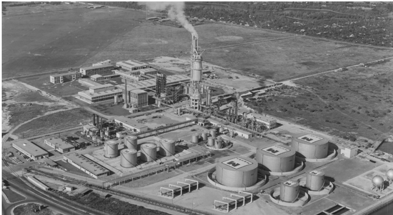
PYROLYSEVÆRKET SET FRA LUFTEN, 1965.
