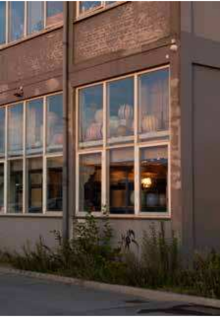
INDUSTRIBYGNING VED OLIEHAVNSBROEN.
