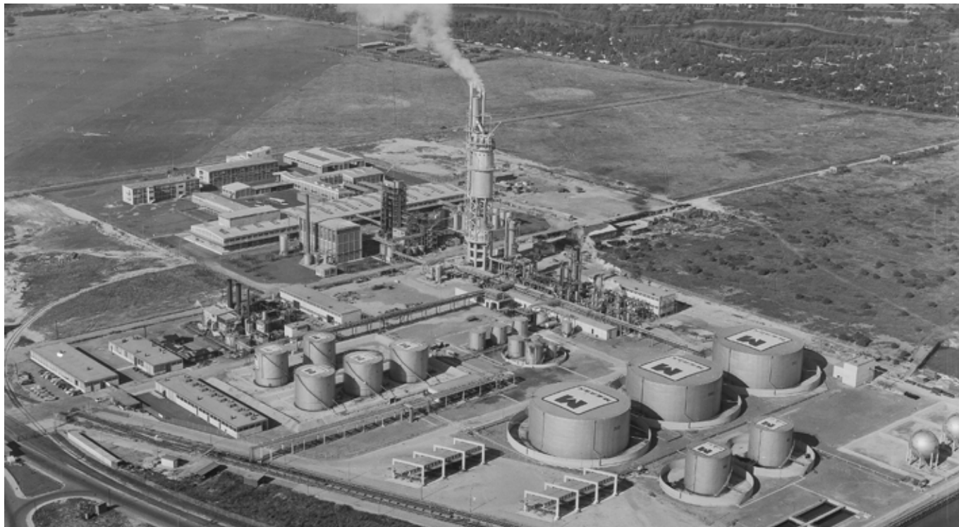
PYROLYSEVÆRKET SET FRA LUFTEN, 1965.
