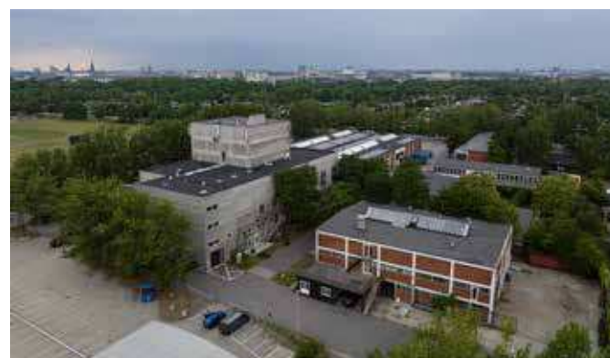
DEN NORDLIGE BYGNINGSENKLAVE SET FRA LUFTEN.
