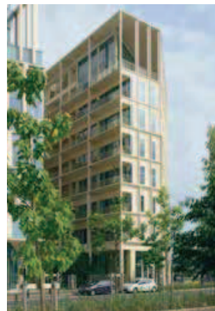
Base og top med en særlig bearbejdning i den samme materialitet
