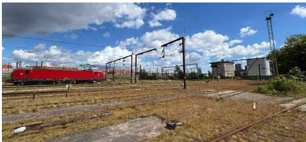
Figur 4-6 Eksisterende forhold ved Askegården. (COWI)
