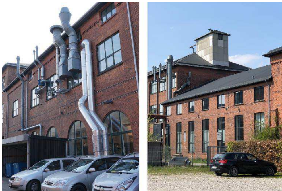
Figur 5-43 Tv. Kølerværkstedets nordfacade. Th. Kølerværkstedets sammenbygning med Nyt Elektrisk-værksted set fra syd. Foto Cobe 2023.
