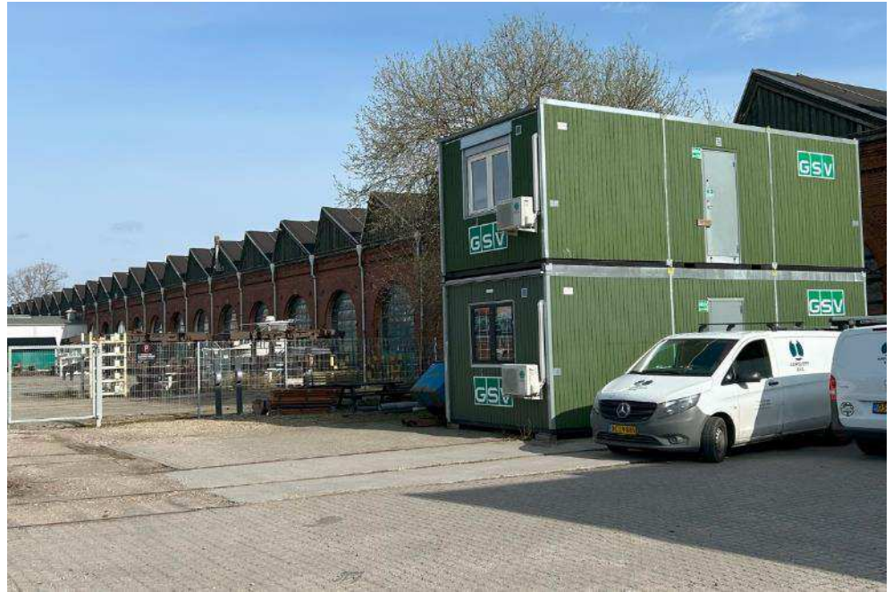
Figur 5-21 Vognværkstedets vestlige facade set fra syd. Foto COWI 2024.
