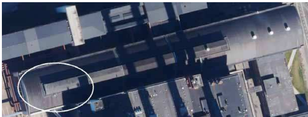
Figur 4-7 H.C. Ørstedværket HCV – Turbinebygning og placering af 30 MW varme-pumper (COWI kort).
