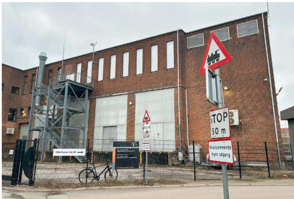
Figur 5-19 Omformerstationen set fra sydøst. Foto COWI 2024.
