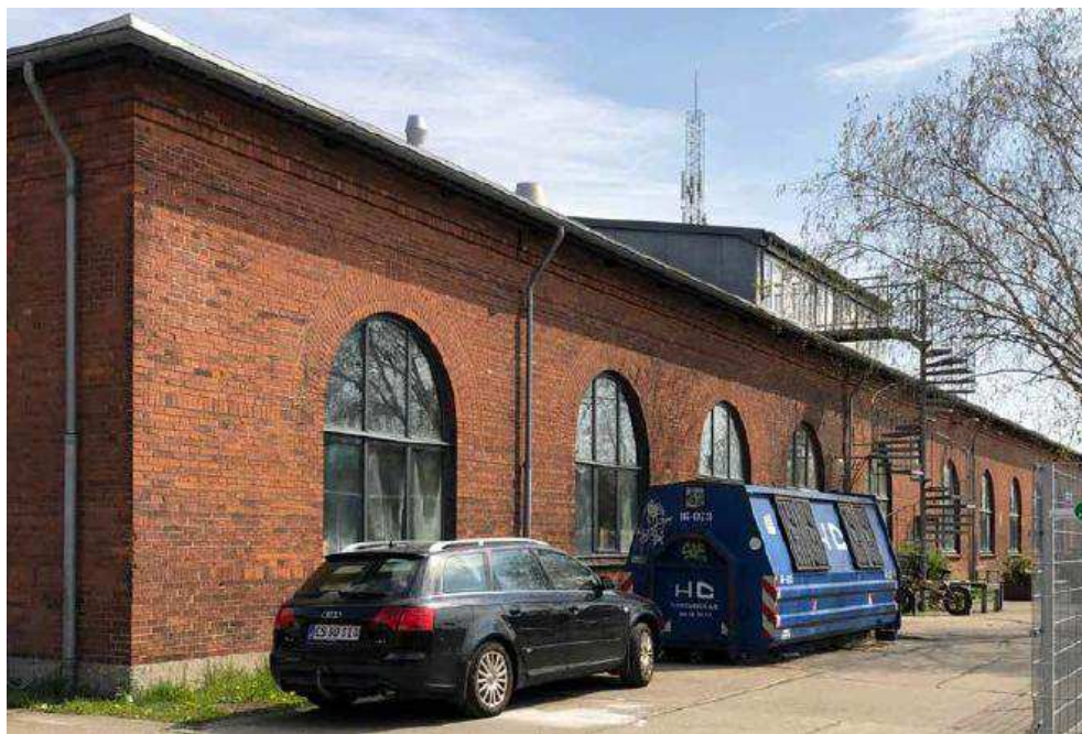
Figur 5-70 Blanketlageret set fra vest. Foto Cobe.
