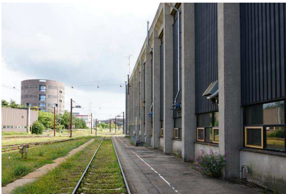
Figur 5-121 Ny eftersynshal set langs den nordlige facade mod øst. Foto Cobe.
