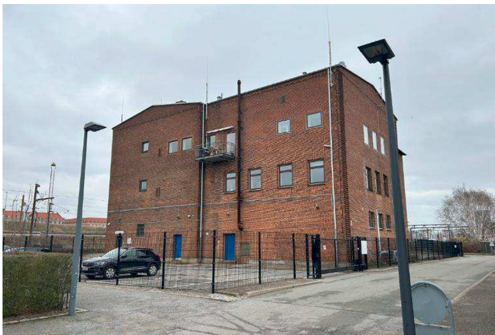
Figur 5-18 Omformerstationen set fra vest. Foto COWI 2024.
