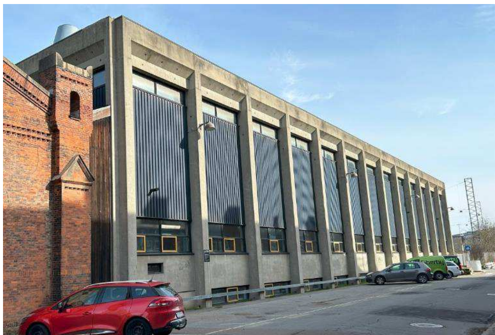
Figur 5-119 Ny eftersynshal set fra syd. Foto COWI.
