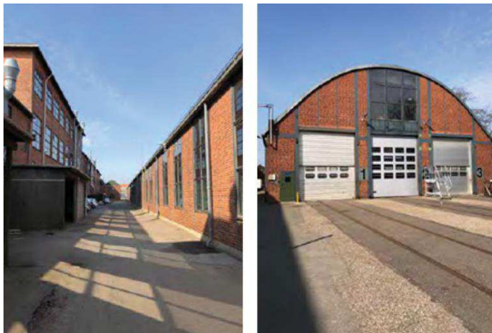
Figur 5-31 Lyntogsløftehallen. Til venstre ses gaderummet mellem Lyntogsløftehallen og 'stangen' i Centralværkstedet. Til højre ses den østlige gavl. Foto Cobe.
