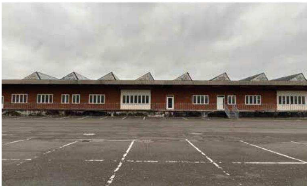
Figur 5-132 Toldkammeret set fra sydøst. Foto Cobe.
