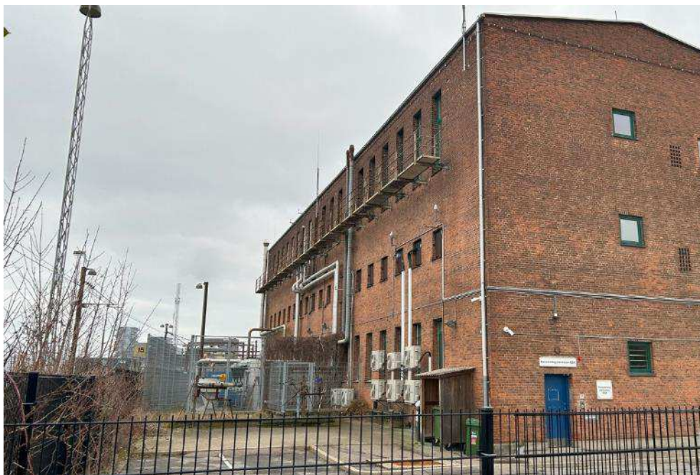
Figur 5-17 Omformerstationens bagside mod jernbaneterrænet, som ligger nord for bygningen. Foto COWI 2024.
