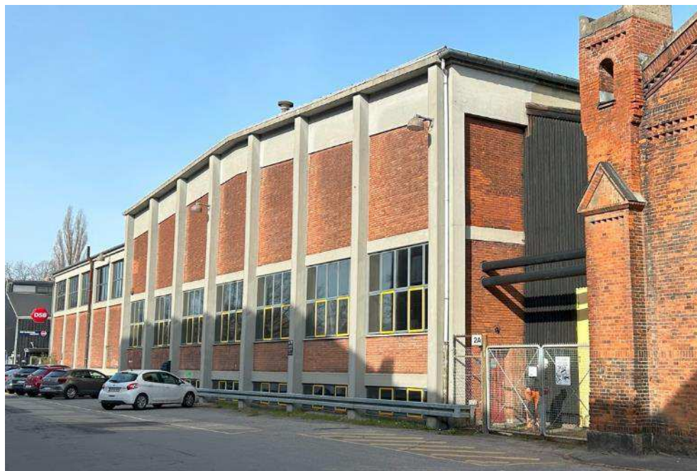
Figur 5-108 Eftersynshal. Foto COWI.
