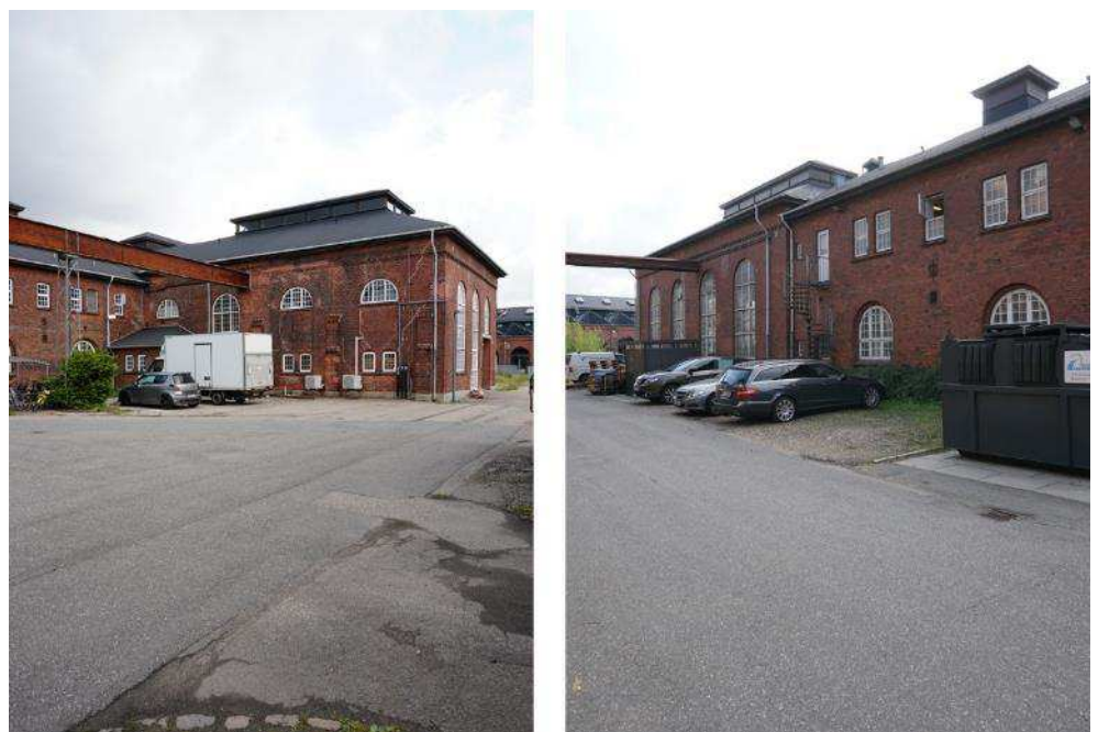
Figur 5-66 Tv. Kraftcentralen set fra sydvest. Th. Kraftcentralen set fra nordvest. Foto Cobe.
