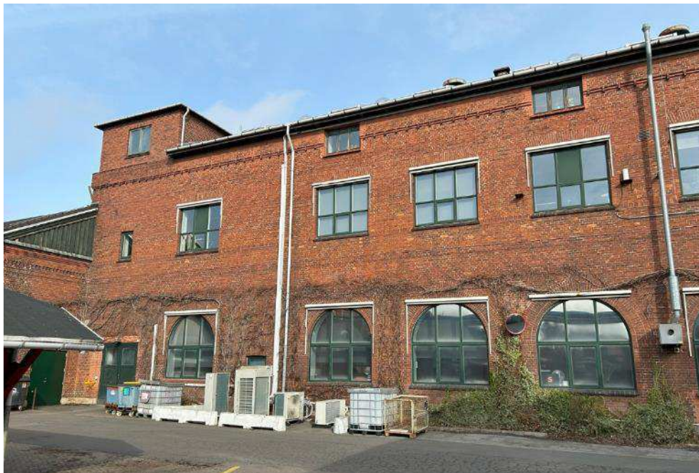
Figur 5-36 El- og sadelmagerværkstedets vestlige del af sydfacaden. Foto COWI 2024.
