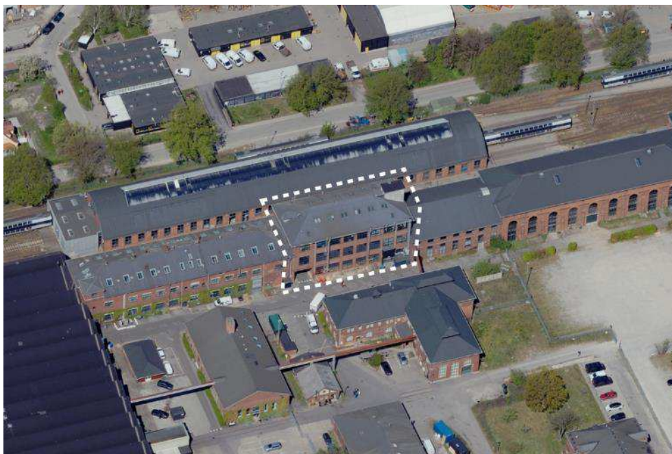
Figur 5-39 Nyt elektrisk værkstedet ses i midten af billedet og er markeret med en stiple linje.
