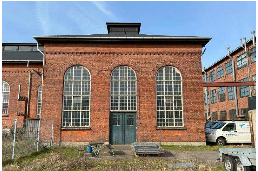
Figur 5-65 Del af kraftcentralens østlige facade. Foto COWI 2024.
