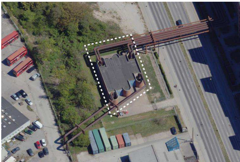
Figur 6-2 Teknisk anlæg ved Vasbygade. Foto COWI.
