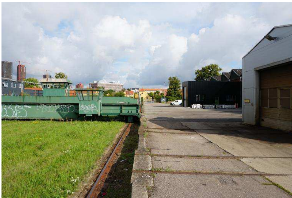
Figur 6-16 Skydebroanlægget set fra syd. Vognværkstedet ses til højre i billedet. Foto Cobe.
