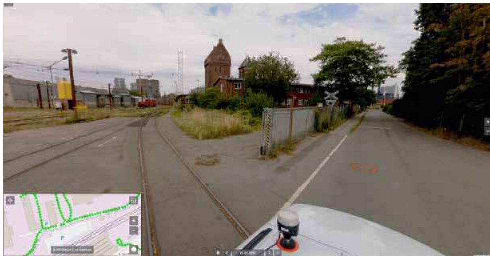
Figur 7-2 Set fra området omkring Otto Busses Vej 4. Midtfor i billedet ses Vandtårnet, der er én af de historiske bygninger, der planlægges indbygget og inddraget i Jernbanebyen. (Foto: COWI).
