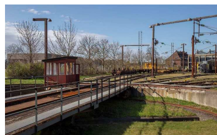
27. Drejeskiveanlæg, bro, førerhus og spor.
