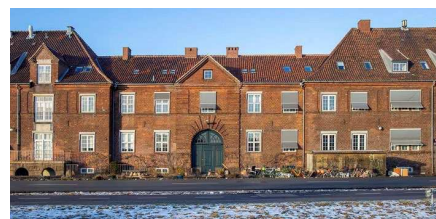
23. Kontor- og administrationsbygning.
