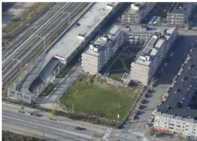
Den tomme grund omgrænset af Ib Schönbergs Allé, Gammel Køge Landevej og Poul Reichardts Vej, hvor der planlægges ungdomsboliger. Parkeringsanlægget til venstre i billedet fungerer som støjskærm. (JW Luftfoto oktober 2014)
