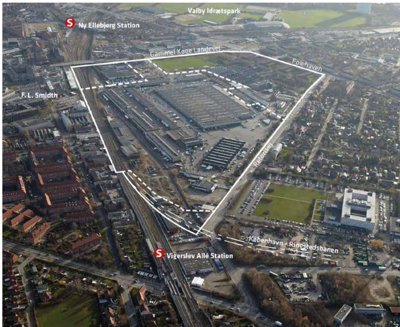
Skråfoto af lokalplanområdet set mod sydøst. Lokalplan 462 er vist med fuldt optrukken linje og tillæg nr. 2 er vist med stiplede linje
