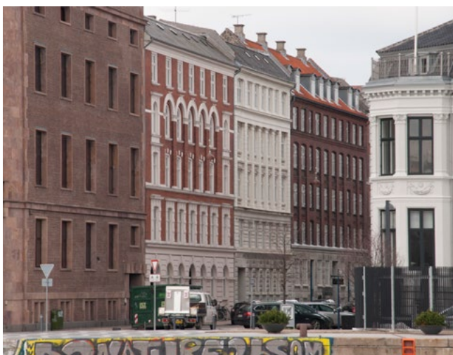
Foto 6. Facaderække med den klassiske opdeling med en under- og overfacade opdelt af gesimser. De forskellige facadebehandlinger, med enten blank mur eller pudsede facader, skaber en horisontal opdeling. Gesimserne understreger de vandrette linjer.
