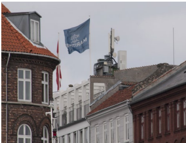
Foto 17. På taget ses en uheldig samling af tekniske installationer, som med fordel kunne være placeret integreret i bygningen eller være blevet dækket ind.
