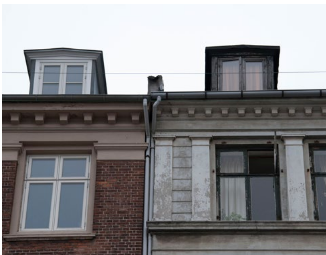
Foto 5. Mange af de oprindelige kviste i området er smalle, opført i træ med saddeltag med lav hældning. De er placeret relativt tæt og rytmisk, uden hensyntagen til underfacadens symmetrisk placerede vinduer.
