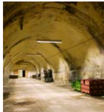
Kælderen under Rød Lagerbygning.
