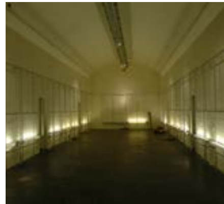
Den eksisterende kælder under pladsen.
