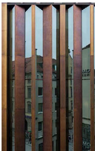
Eksempel på facadeparti i metal og glas: Joseph Pschorr Haus, München. Arkitekt: Kuehn Malvezzi.
