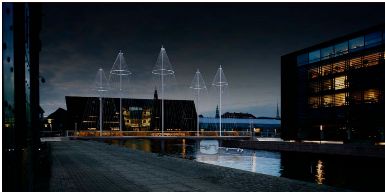
Broen belyses ved projektører, der lyser ned på gangarealerne.
