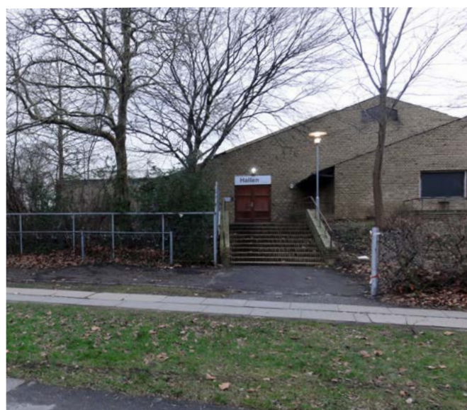
Ankomst til eksisterende hal fra Åkandevej
