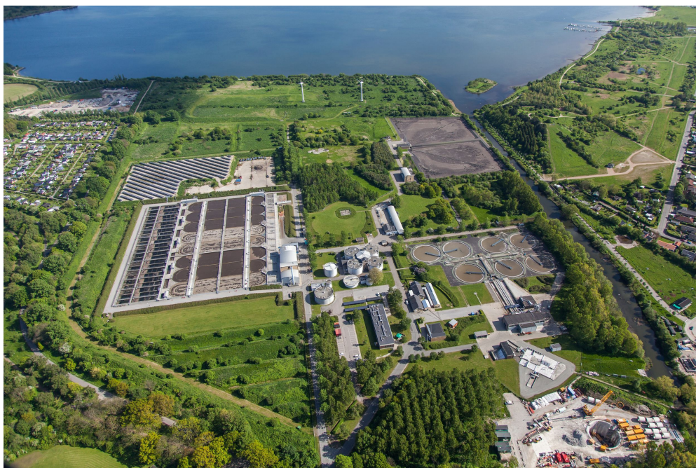
Renseanlæg Damshusåen. Foto: Hviid Photography
