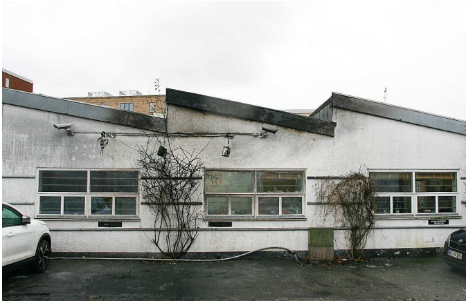
Karakteristisk industrielt tagprofil i lokalplanområdet ud til Yderlandsvej.
