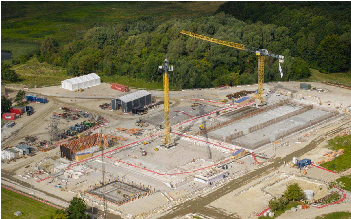
Figur 2. Opførelsen pågår. Kælderkonstruktioner og fundering er afsluttet, og byggeriet foregår nu over terræn
