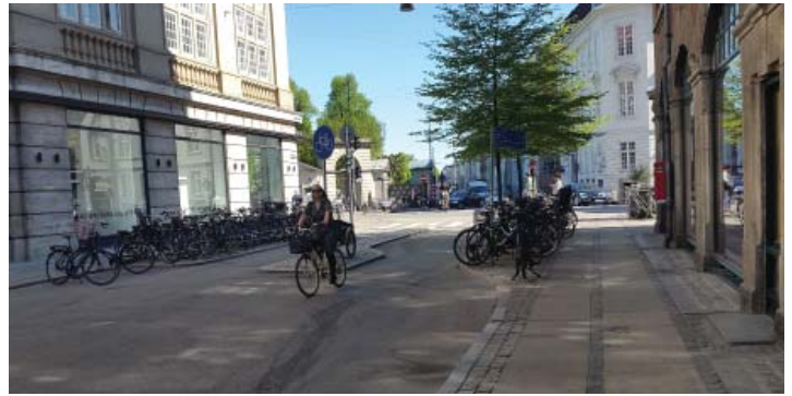
Eksempel på lokal indsnævring af kørebanen, som giver plads til træer og cykelparkering, Møntergade
