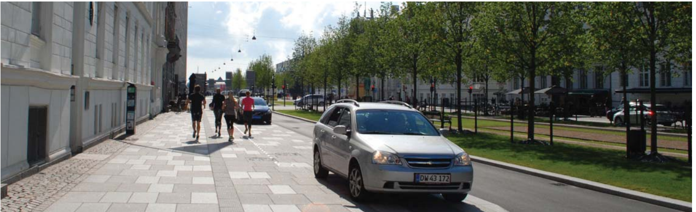
Eksempel på cykelgade, hvor kørebanen er indsnævret. De brede fortove har også afmærkede båse til varelevering og parkering, Sankt Annæ Plads.
