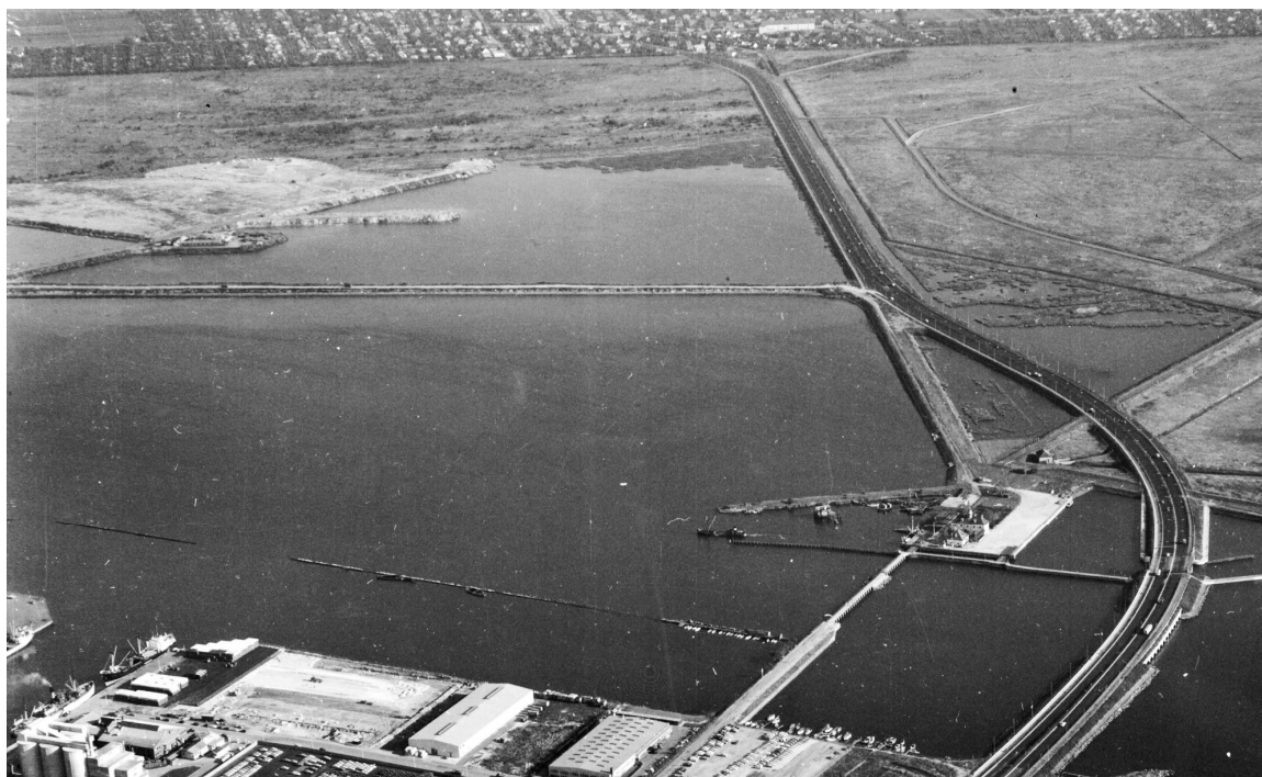
Figur 15.1 Flyfoto fra ca. 1962. Opfyldningen af det inddæmmede område (øverst tv. i billedet) er påbegyndt. I forgrunden th. ses "Slusen" og Sjællandsbroen. (Foto fra kb.dk/danmarksetfraluftten)
