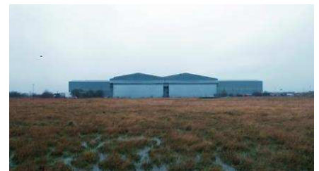
Tunnelfabrikken set fra øst mod vest. Bygningen fremstår med karakteristiske taghældninger og store lukkede facadepartier.
