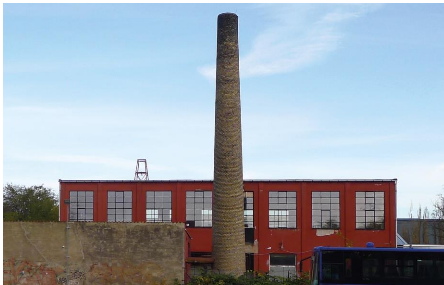
Bygningen på ejendommen Yderlandsvej 1 er ikke registreret i SAVE registreret, men ønskes bevaret i en ny lokalplan med mulighed for ombygning. Opført i 1952.
