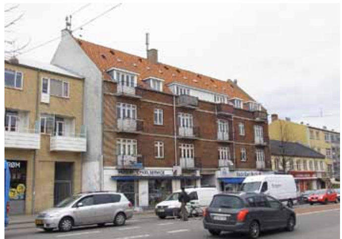
Gavl og gadefacade
