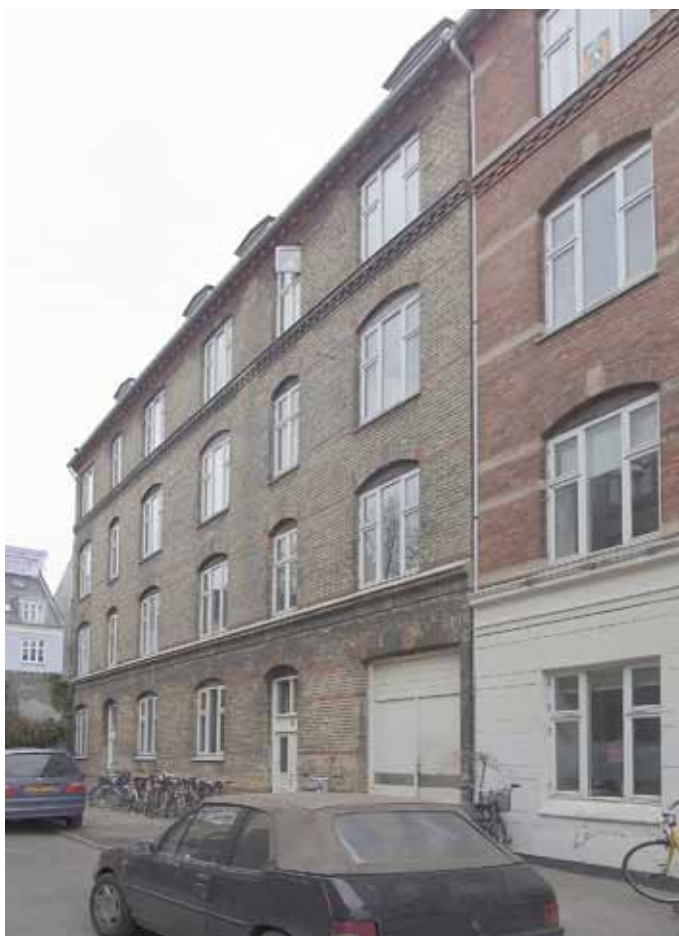
Udsnit af gadefacade mod blind vej
