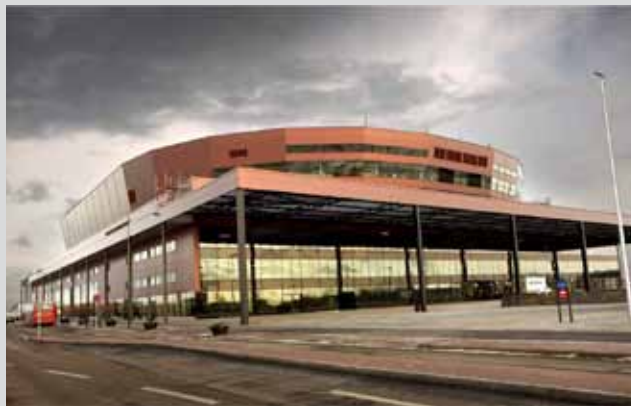
Hyllie Arena i Malmö-forstaden Hyllievång med 15.500 tilskuerpladser er centralt placeret i et nyt byudviklingsområde og kan i størrelse og anvendelse sammenlignes med den i Ørestad planlagte multiarena.
