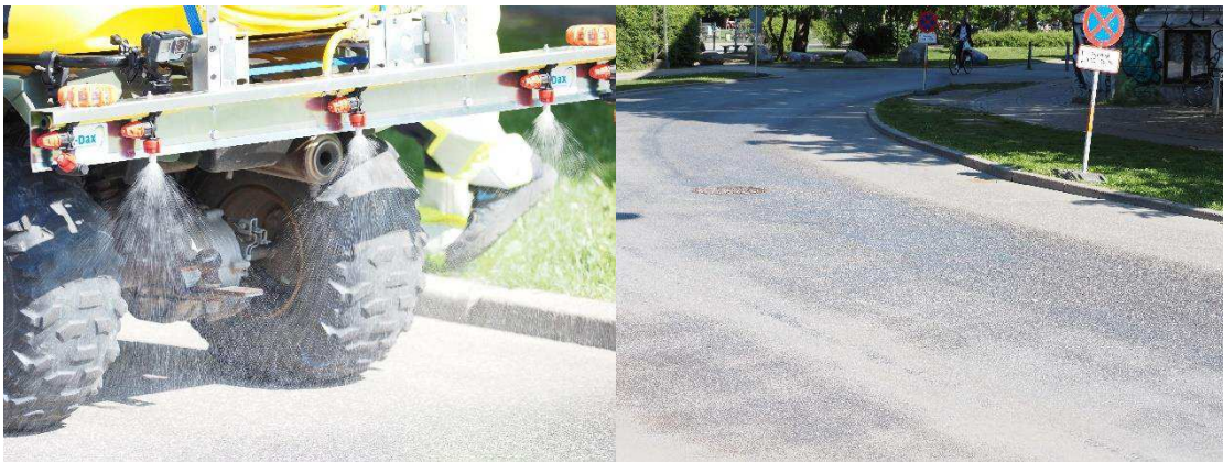
Figur 11. Applicering af NO x OFF belægning på asfalt.
