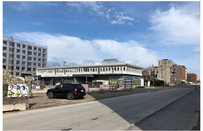
Torveporten set fra vest med de sidste tilbageværende bygninger fra Københavns Grønttorv. Bygningerne nedrives og det sidste byggefelt opføres med erhverv og ungdomsboliger.
