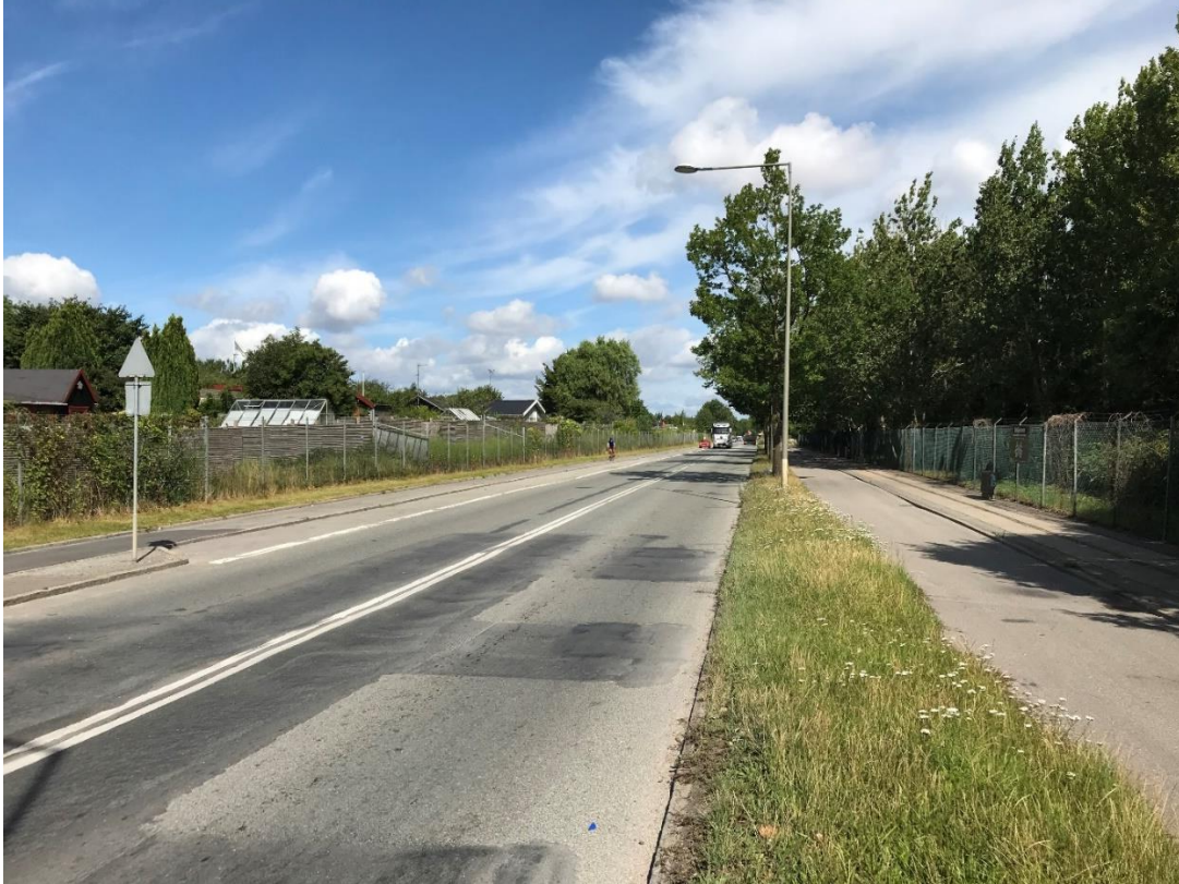
Figur 23-4 Eksisterende forhold på Forlandet syd for Kraftværksvej – set mod nord, 2020.
