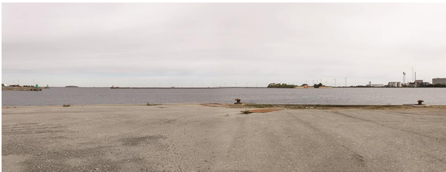
Figur 24-10 Fotostandpunkt 3 fra Redmolen på Indre Nordhavn mod Middelgrunden, eksisterende forhold /290/.
