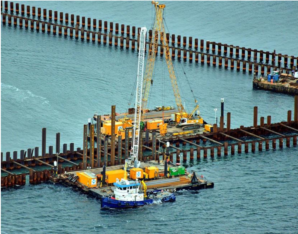
Figur 3-21 Eksempel på flydende grej i forbindelse med ramning af fangedæmning på Nordhavnsudvidelsen, Züblin A/S /4/.
