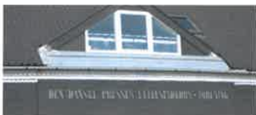
Facadeudsnit af den tidligere bestyrerbolig: Den danske Presses Fællesindkøbsforening. Bygningen fungerer i dag dels som bolig (1.sal), dels som cafe og designvirksomhed. Hele bygningsfacaden ses nedenfor.
