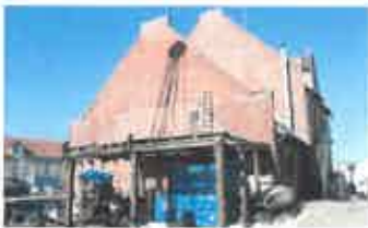
Kedel og Maskinhus fra 1909.
