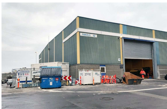
Pakhus 52 beliggende øst for lokalplanområdet og Pakhus 53.
