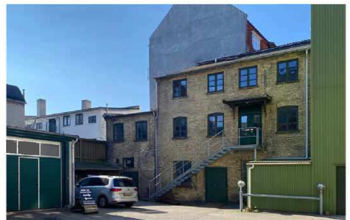
Baghuset (Hannovergade 8B) set fra gårdrummet.
