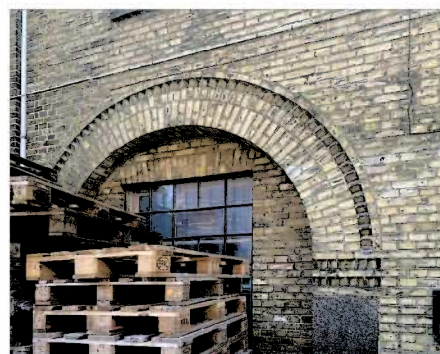
Udsnit af baghusets gule teglstensfacade med et muret buestik omkring vindue.
