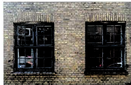
Udsnit af forhusets gule teglstensfacade mod Hannovergade med originale trævinduer og murstik over vinduer.
