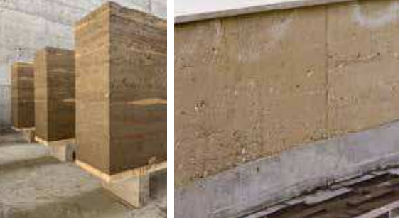
Jord Stampet lerjord kan bruges som bærende element i lette konstruktioner, det er potentielt lokalt tilgængeligt i Nordør og det vil også kunne genanvendes i et cirkulært perspektiv.
