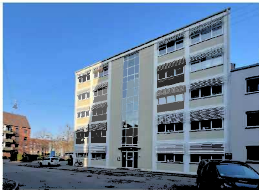
Eksisterende byggeri på Lyngbyvej 17, set fra bagsiden, ved nedkørslen til parkeringskælderen ved Føtex.
