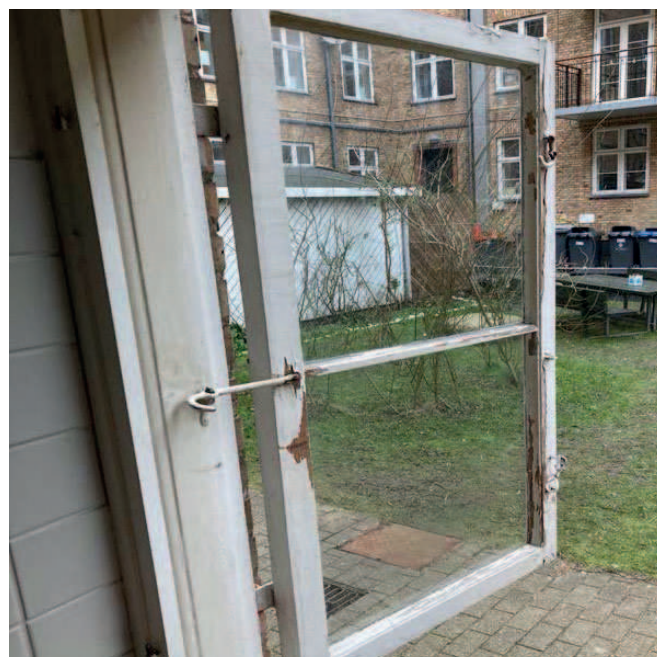
Oprindelige vinduer istandsættes og energioptimeres
