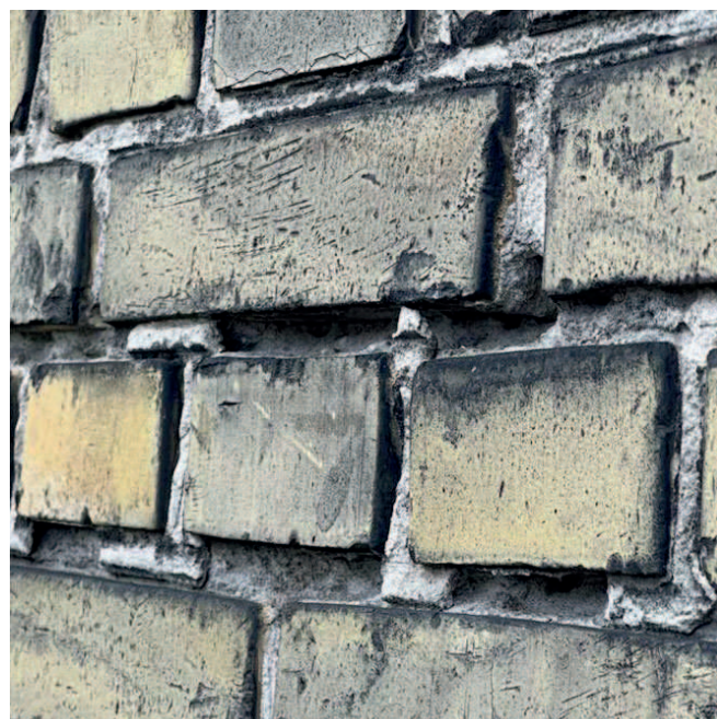
Facader istandsættes og omfuges
