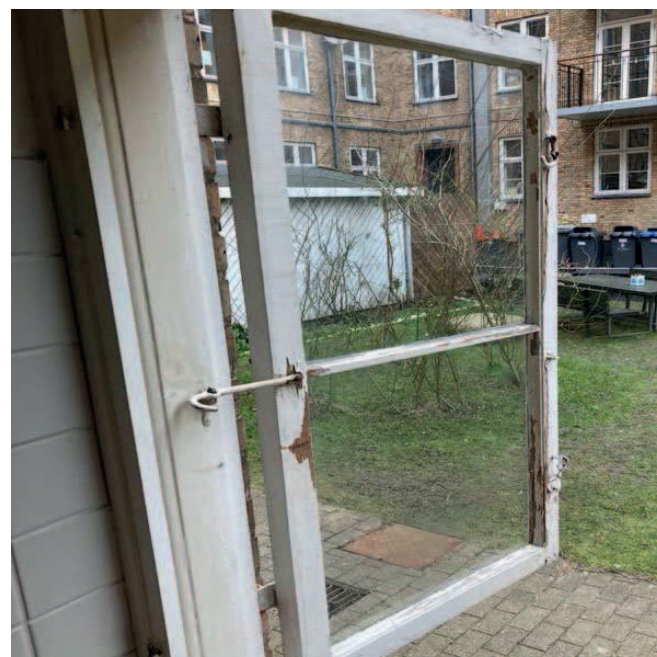
Oprindelige vinduer istandsættes og energioptimeres
