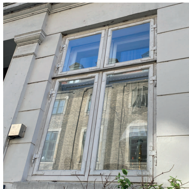
Der udføres snedker gennemgang af vinduer
