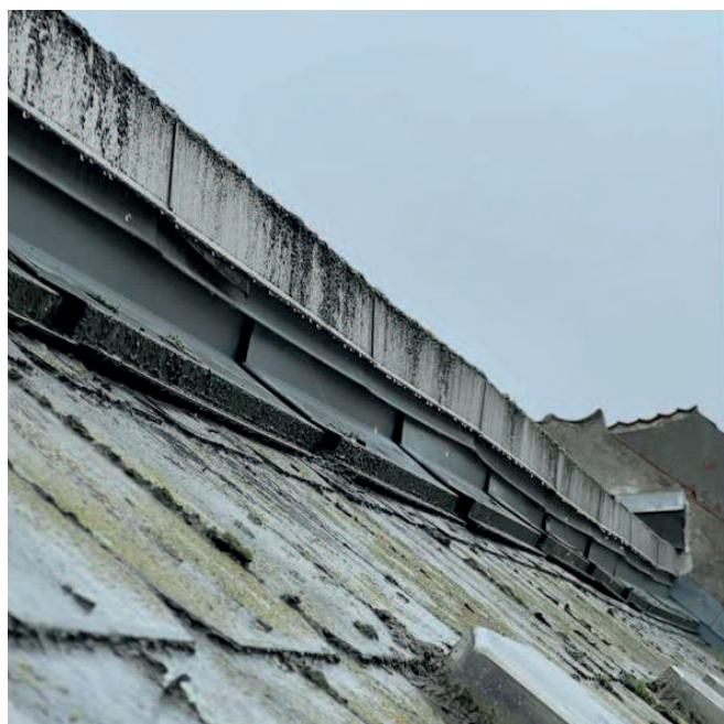
Tagbelægning udskiftes til naturskifer BYGNINGSFORNYELSER 2025
