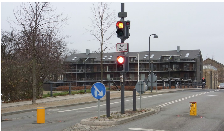
Den mekaniske bussluse syd for Frederiksholmsbroen.
