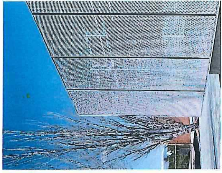
afskærmning med strækmetal eller elefantrist / galv. stål
