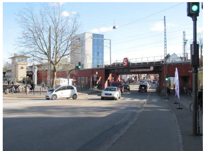
Vanløse station - set fra krydset Vanløse Allé/Jernbane Allé
