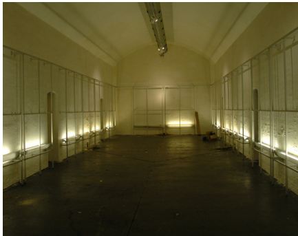
Den eksisterende kælder under pladsen.
